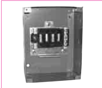
Interior de centro de carga de 4 circuitos (figura 2)
